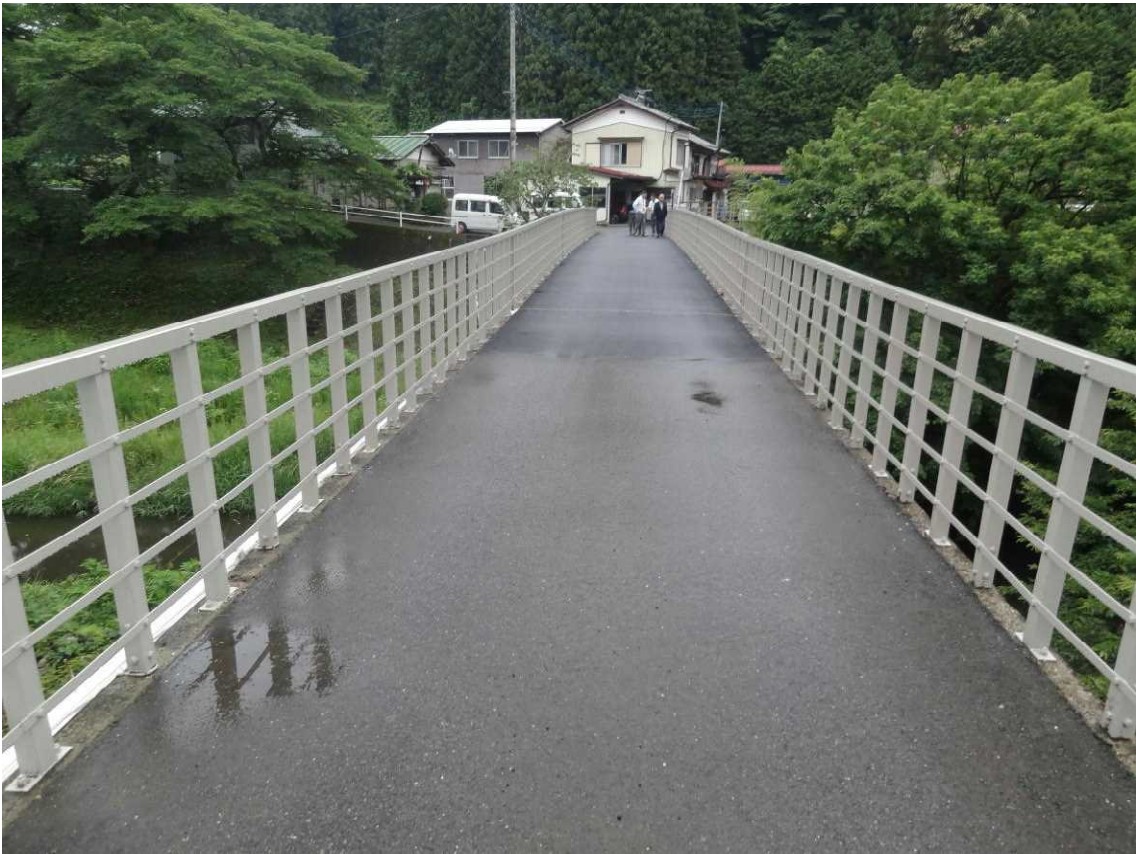
村道菅田線菅田橋
