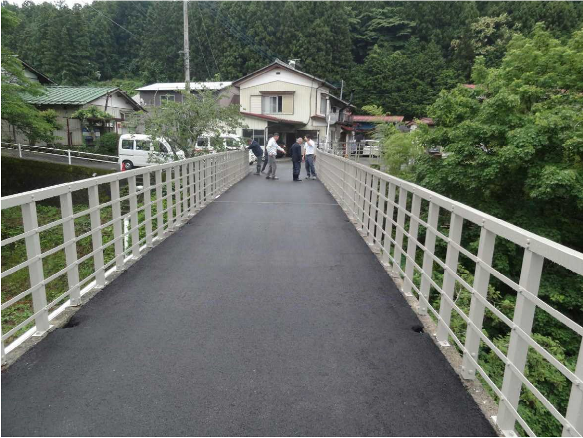
村道菅田線菅田橋
