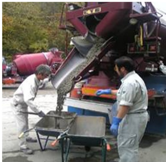
図-6.1.2.1 現場まで運搬された自己治癒コンクリート
