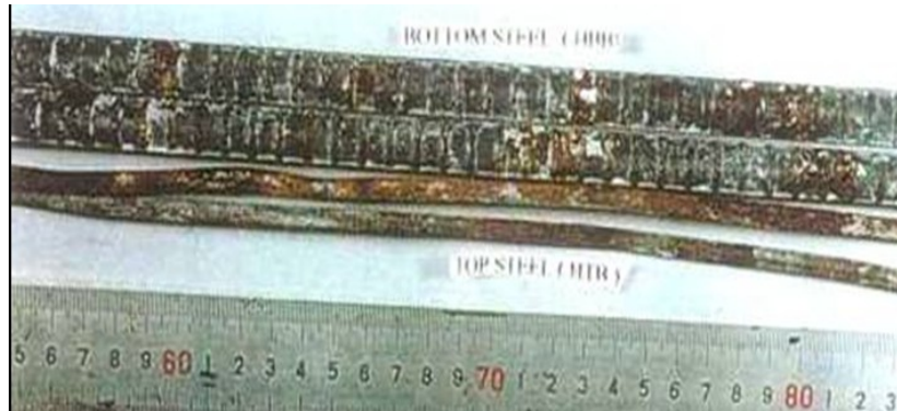
図－3.1.3.11 23 年間暴露した RC はり供試体中の主鉄筋の腐食状況の一例 (上) 引張側鉄筋 (下) 圧縮側鉄筋[30]
