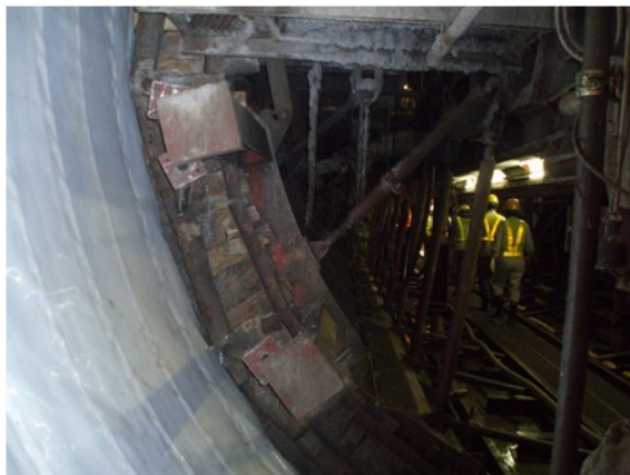
図-6.1.1.1 打設区間に設置された防水シート
